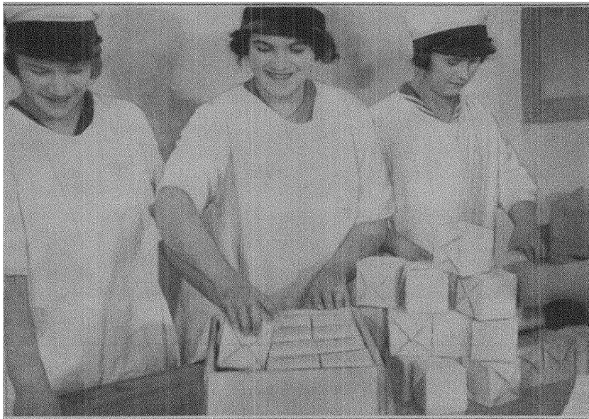
Interiör från Kooperativa Förbundets Margarinfabrik i Norrköping.
